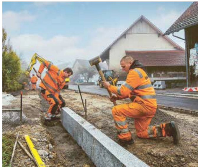
Umbau in Schlattingen: Die Haltekante wird erhöht.
