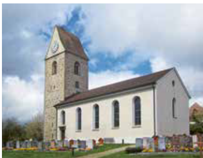
Der aus Bruchsteinen erbaute Kirchturm von Lustdorf diente einst als Wehrturm.
