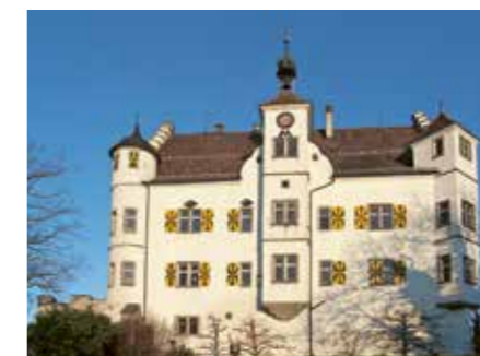
Schloss Sonnenberg 2011 – vor Beginn der bis heute andauernden Bauarbeiten.
