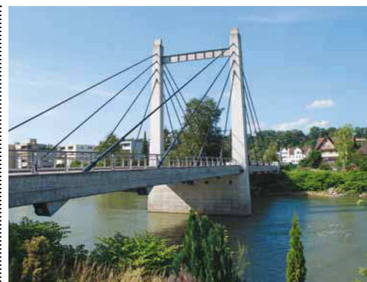
Modern und markant: Schrägseilbrücke zwischen Kradolf und Schönenberg.
