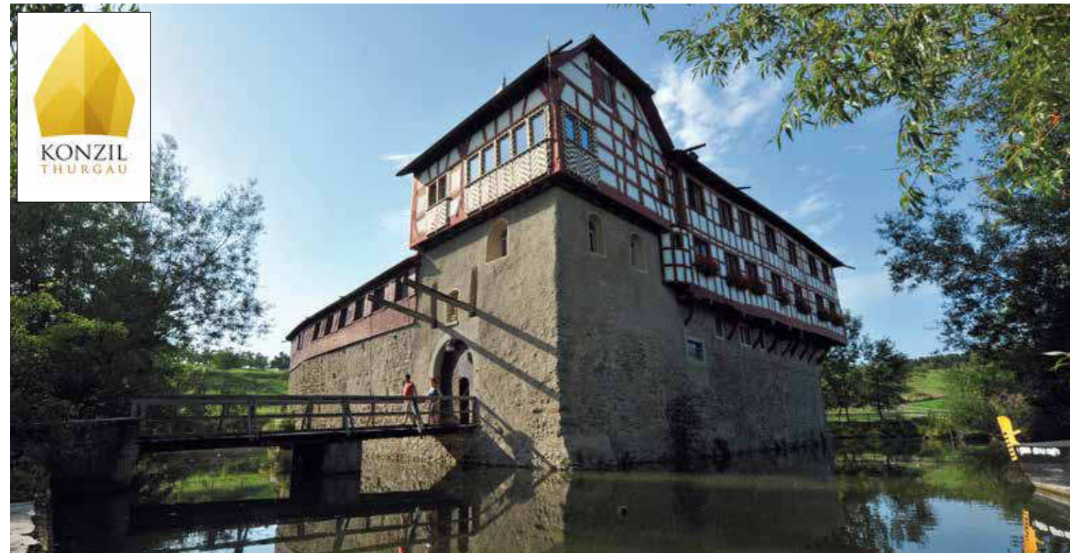
Fachwerk auf soliden Mauern: Wasserschloss Hagenwil, rund 800 Jahre alt.
