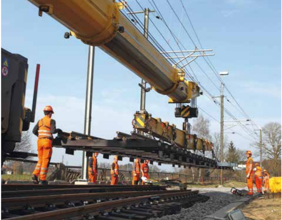
Auch am Tag verlegen Gleisarbeiter zurzeit Schienen in Akkordarbeit.
