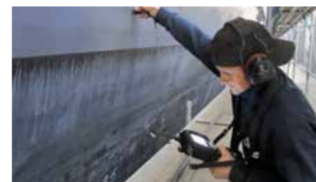
Ein Mitarbeiter überprüft den Anstrich.
